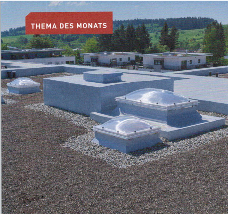
▲ Lichtkuppeln und Lüfter wurden mit Formteilen ins Flachdach integriert
