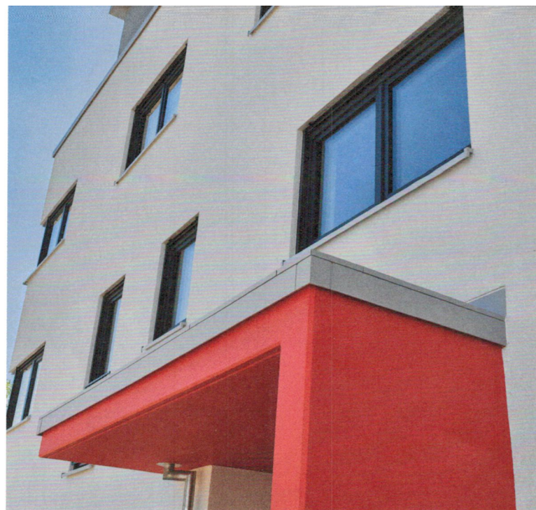
▲ Auch die Abdichtung der Vordächer wurde von den Dachdeckern erledigt
