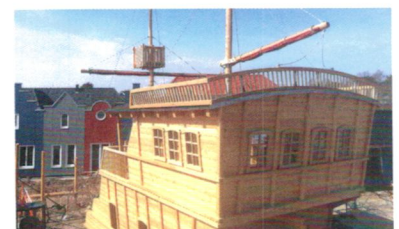
ABDICHTUNG Die Planken schützen
