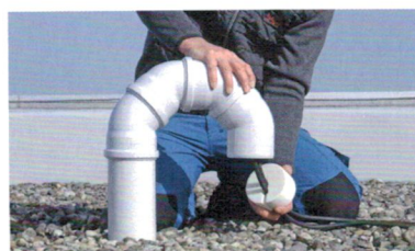
FLACHDACH Die Leitungen führen
