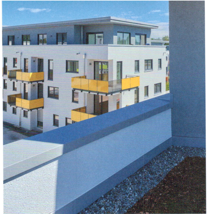
▲ Die Brüstungen erhielten passgenaue Mauerabdeckungen aus Aluminium
