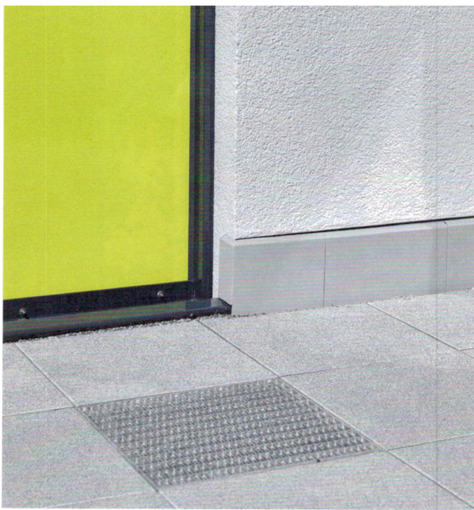
▲ Die Aluprofile, wie hier auf einem Balkon, wurden nach Aufmaß gefertigt
